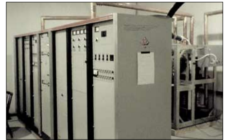
Der 50-kW-UKW-Sender von Radio 24 auf dem italienischen Pizzo Groppera
